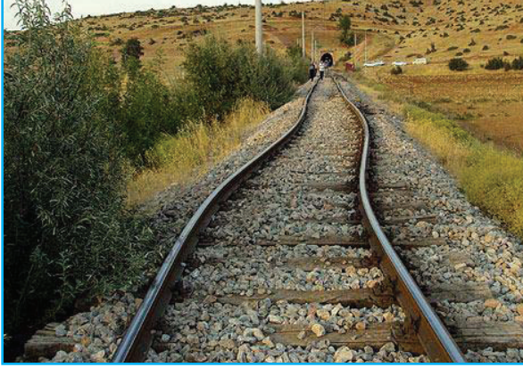
Genleşme sonucu bozulan raylar
